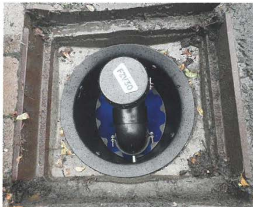
Rechtssichere Köderstation zur Montage in Kanalschächten oder integriert in den Regenwasserablauf
